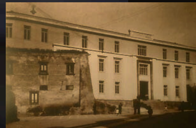
Vista di una parte ormai distrutta e non più presente del Monastero di S. Scolastica. Archivio Storico
